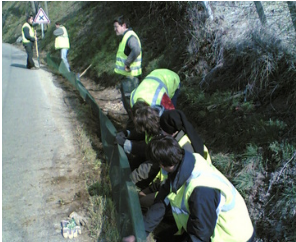
Crédit photo : LPO Isère - Chantier de Chirens
